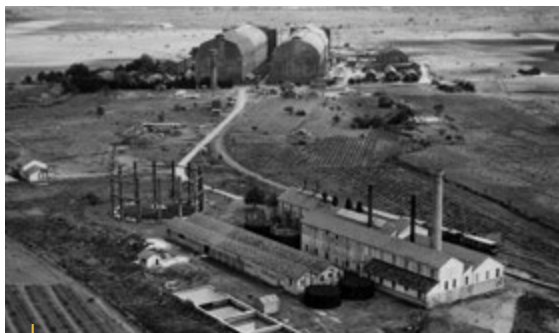
USINE D'HYDROGÈNE SUR LA BASE DE BARAKI 1917
