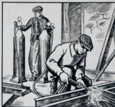
LA FLAMME TRÈS CHAUDE DU CHALUMEAU PERMET DE FONDRE ET DE COUPER LES MÉTAUX
